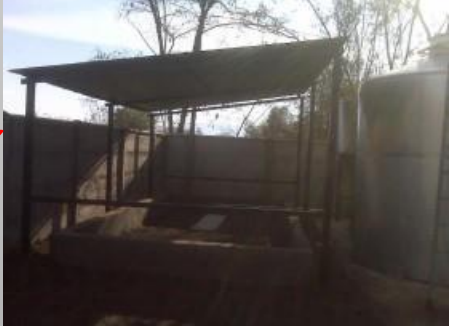
PLANTA DE LECHOS DE SECADO EXISTENTE EN MAL ESTADO
