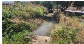
CANAL CAJON DE HORMIGÓN
