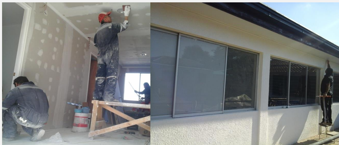
Cuadrilla de obrero trabajando en la obra Remodelación y Ampliación SAPU, CESFAM Carlos Trupp. Fuente: Departamento de Salud, 2015
