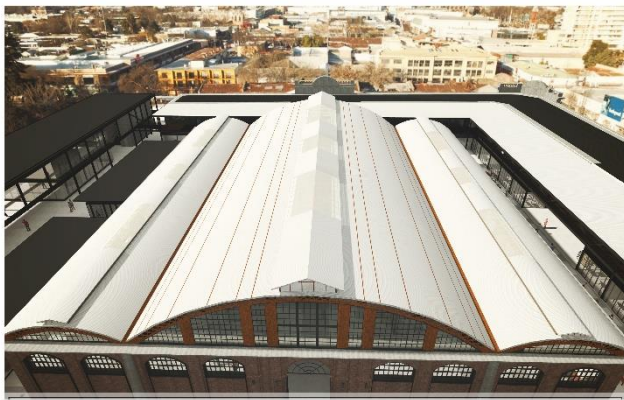
PROGRAMA PUESTA EN VALOR DEL PATRIMONIO Restauración Mercado Central Municipal de Talca 13
